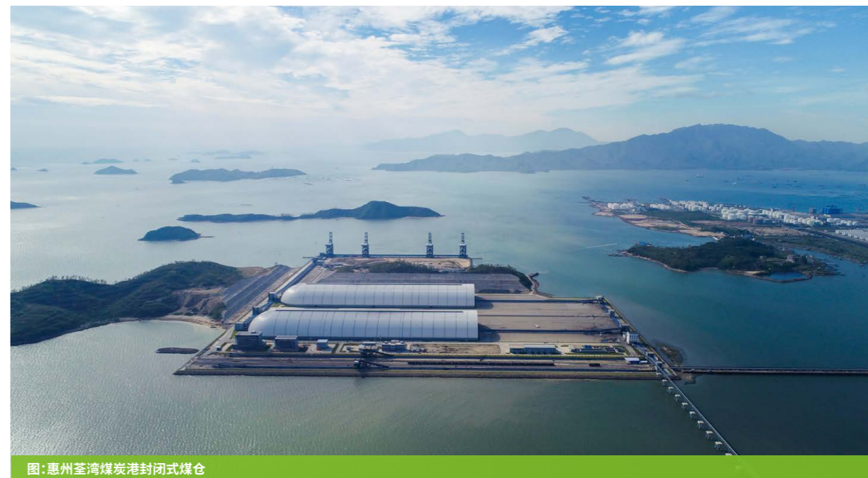
图：惠州荃湾煤炭港封闭式煤仓
