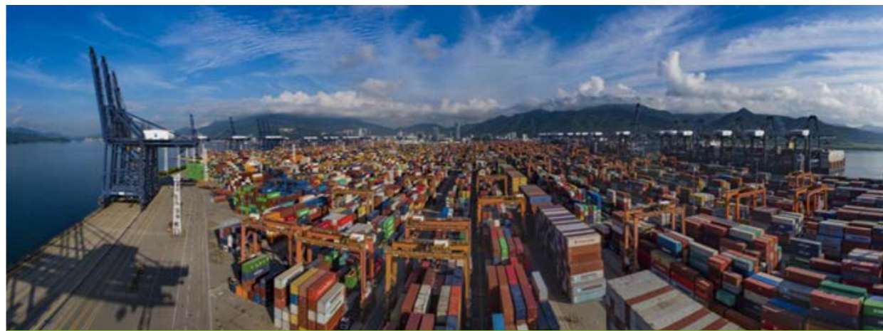
图：盐田港码头电力龙门吊
